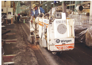
切削（レベルダウン）施工
